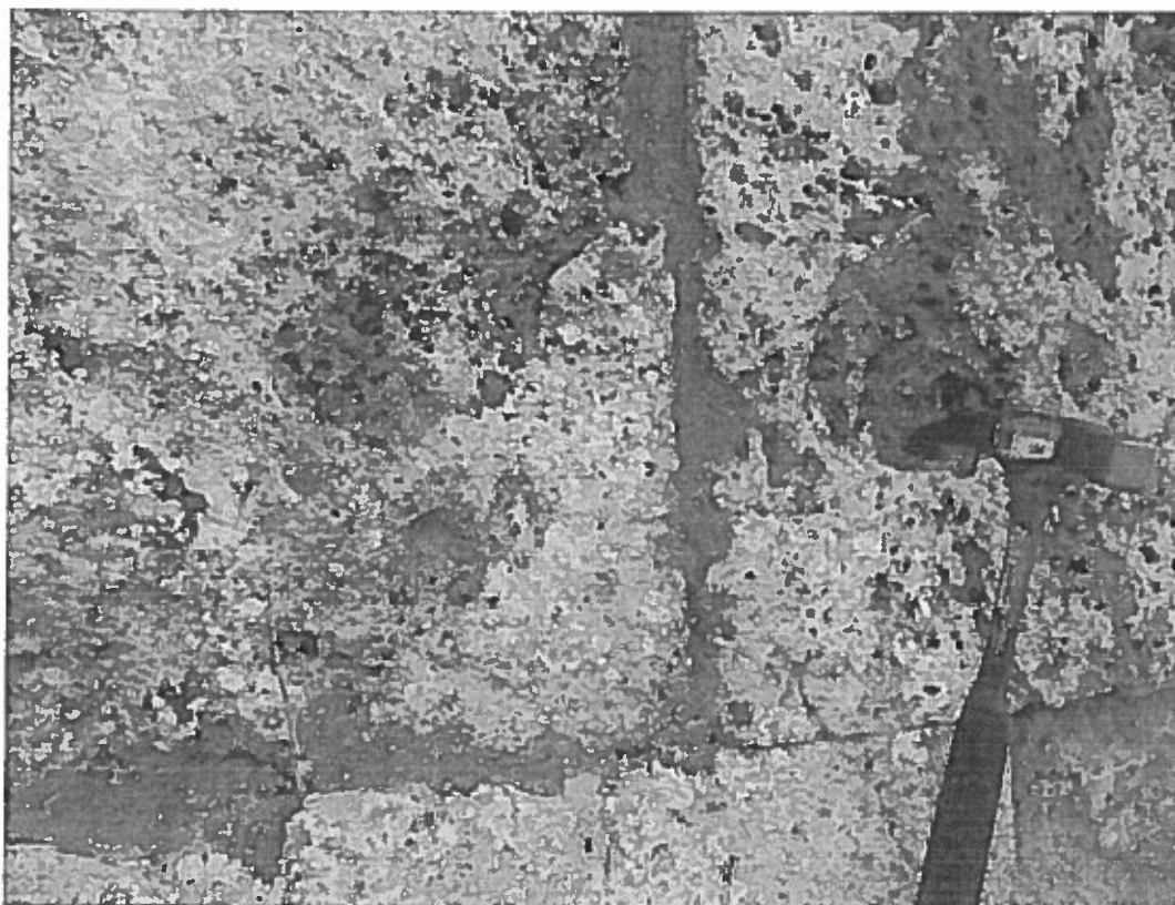
Particolare di Porta Capuana che evidenzia la costituzione travertinosi dei blocchi
